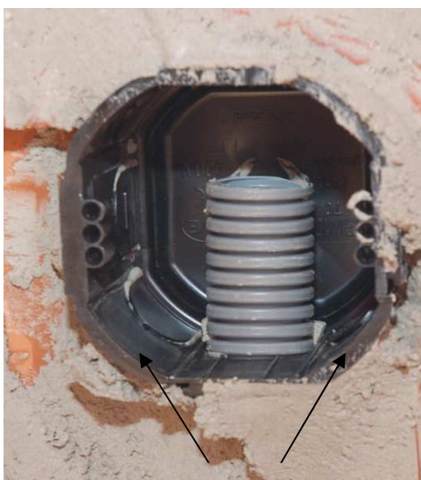
Gips muss sich durch Ritzen durchdrücken
